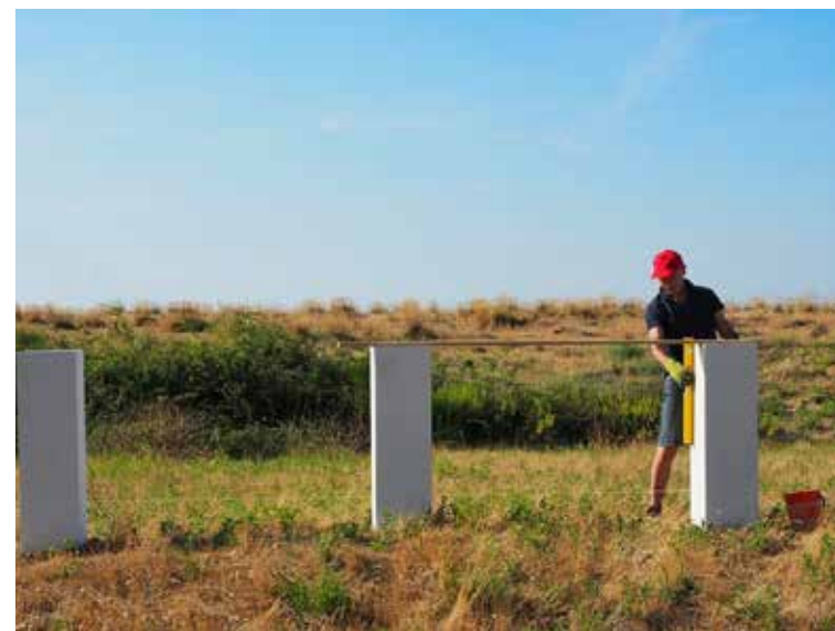
Una fase dell'allestimento
